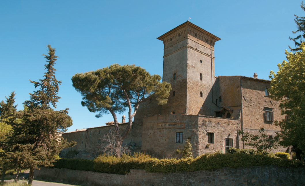
Castel Rubello - ingresso lato sud Archivio Comune di Porano
